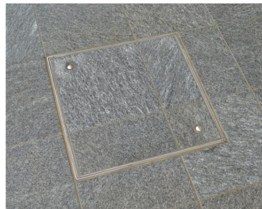
Конструкция состоит из каркаса с подъемно-опускным механизмом и заполнения материалом покрытия. В конструкции предусмотрено отверстие для крюка.
