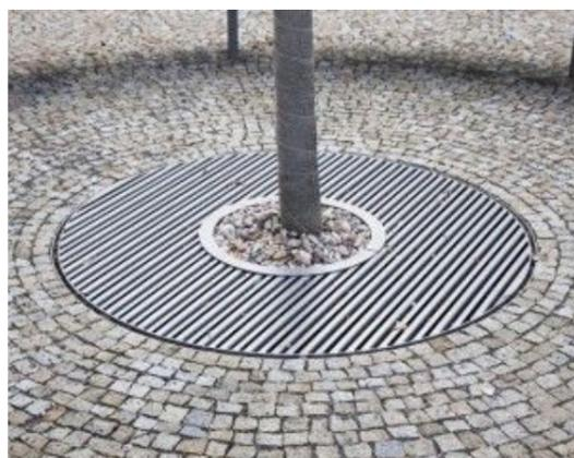
Приствольная решетка состоит из модульных элементов, установленных на каркас.
